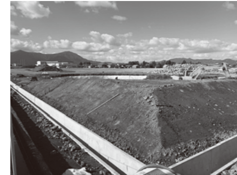
工事中の道の駅。奥は旧蔵生小
